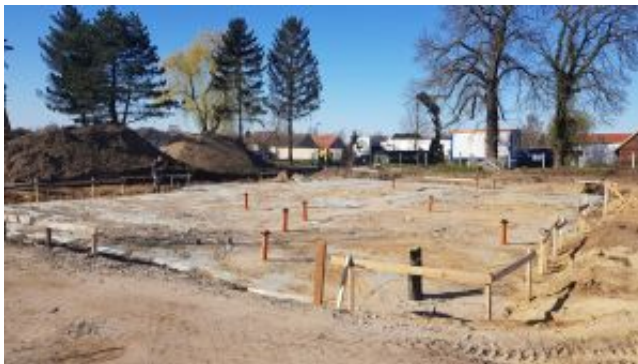
Verlegung der Grundleitungen
